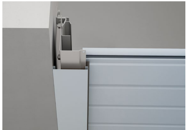
Montaż w otworze - maskownica w otworze
