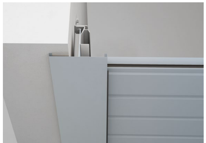
Montaż w otworze - maskownica przed otworem
