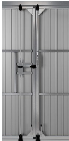
Skrzydło czynne ryglowane trzypunktowo przy H > 2700 [mm] - widok od wewnątrz.
