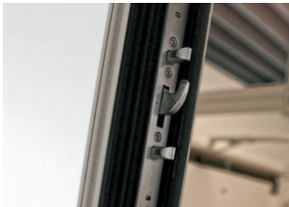
Mehrfachverriegelung mit integrierten Haken und Bolzen
