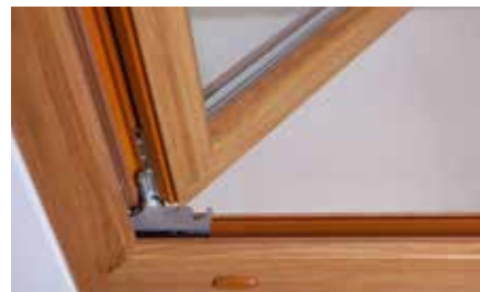
Multi Power – völlig verdeckt liegende Scharniere
