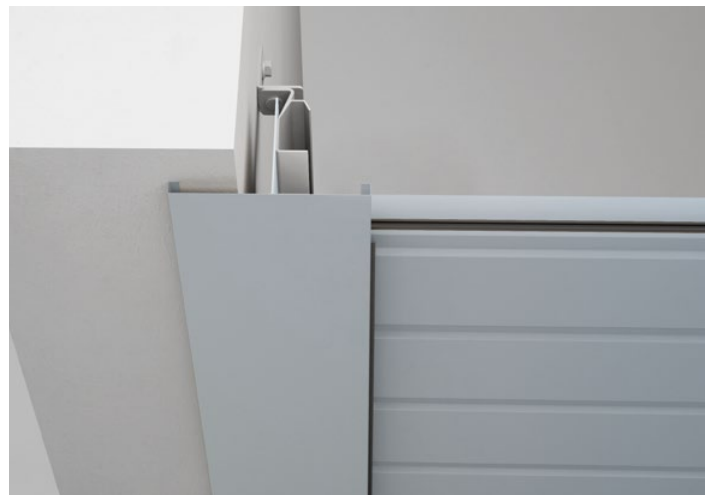
Montaggio in foro - carter davanti foro
