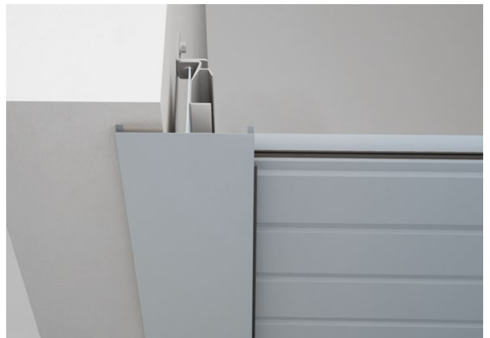
Montaggio in foro - carter davanti foro
