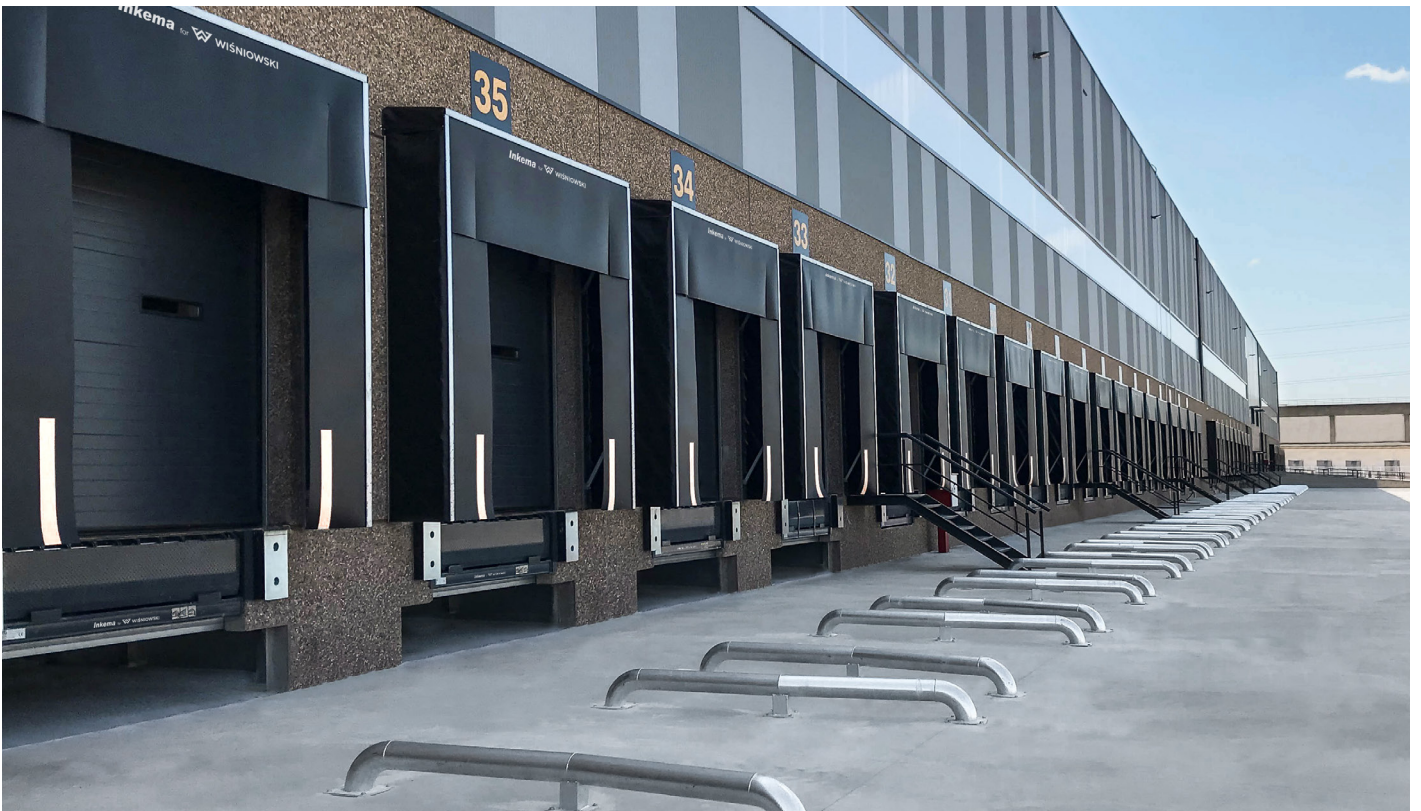
Pedana di carico e scarico (rampe) RH12B.
