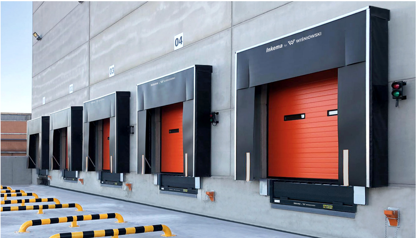
Pedana di carico e scarico (rampe) RH12B.
