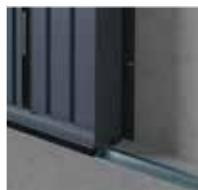
Rail de guidage inférieur
